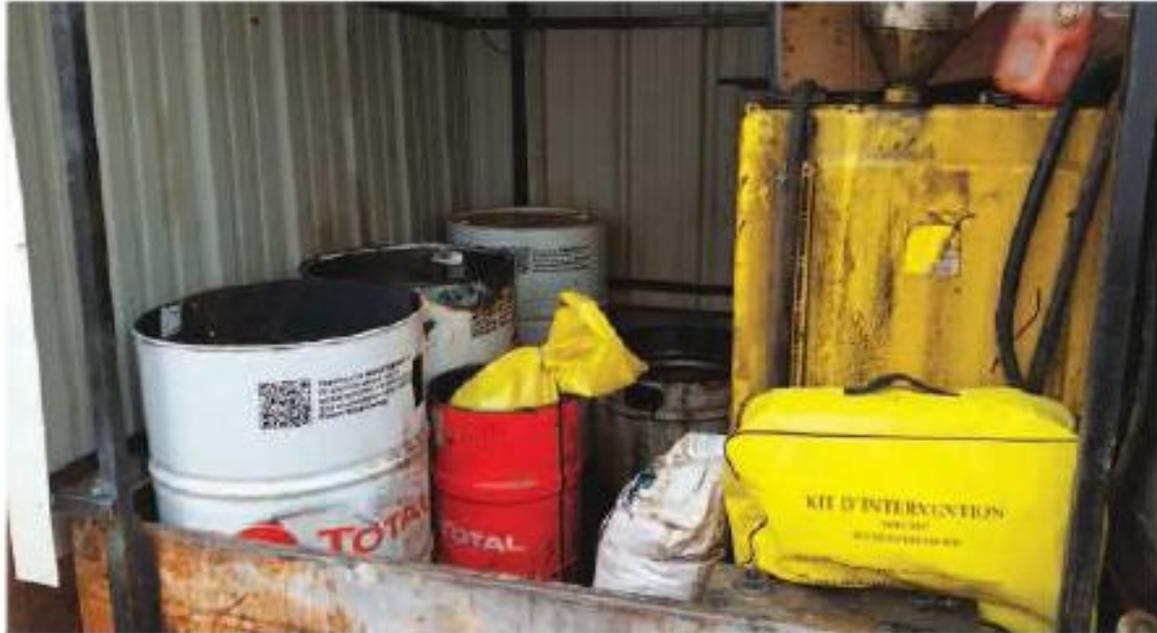
**Fig. 2. Exemple d'une aire de stockage des matériaux polluants, constituée d'un conteneur/bungalow étanche associé à un kit anti-pollution. Certains produits sont isolés du sol et disposés sur des bacs de rétention (source Mc Donald D., 2018.)**
