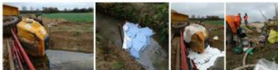
Exemple de pollution en cours d'eau : découverte de la pollution, aménagement d'un barrage au kits anti-pollution au aval puis sous la machine afin de contenir la pollution, récupération de l'eau souillée dans des bidons et évacuation
