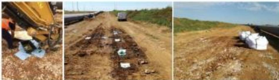
Exemple de pollution sur sol à nu : installation d'un bac de rétention au niveau de la fuite, utilisation de kits anti-pollution, évacuation de la terre souillée via bagag dans un contenant dédié
